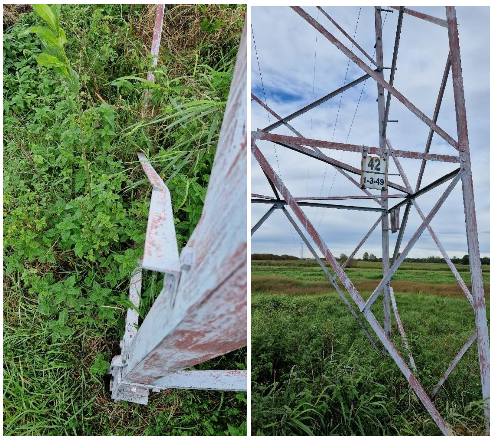
Grafika 36 Uszkodzona konstrukcja słupa nr 42.
