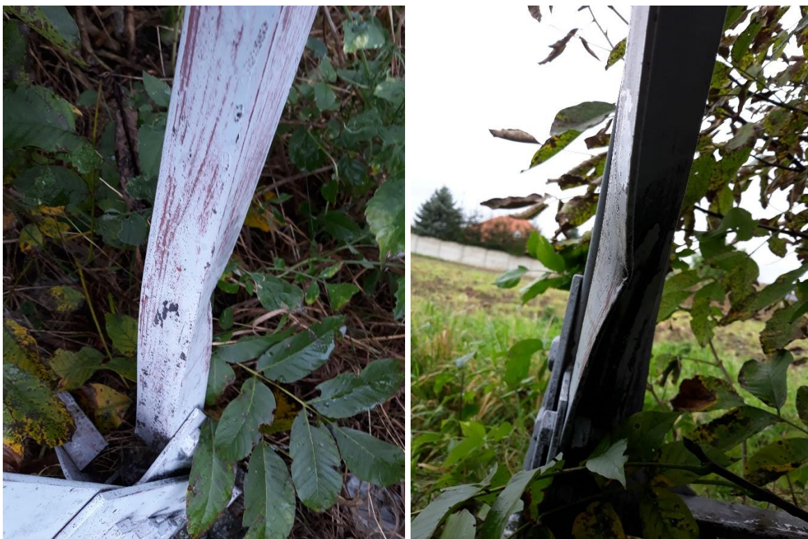
Grafika 14 Uszkodzona konstrukcja słupa nr 14.
