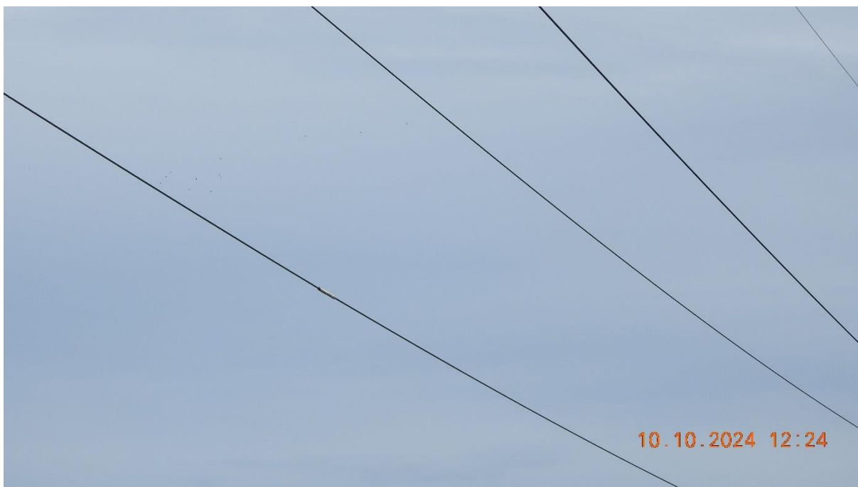
Grafika 45 Złączka na przewodzie fazowym L1 w przęśle 46-47.
