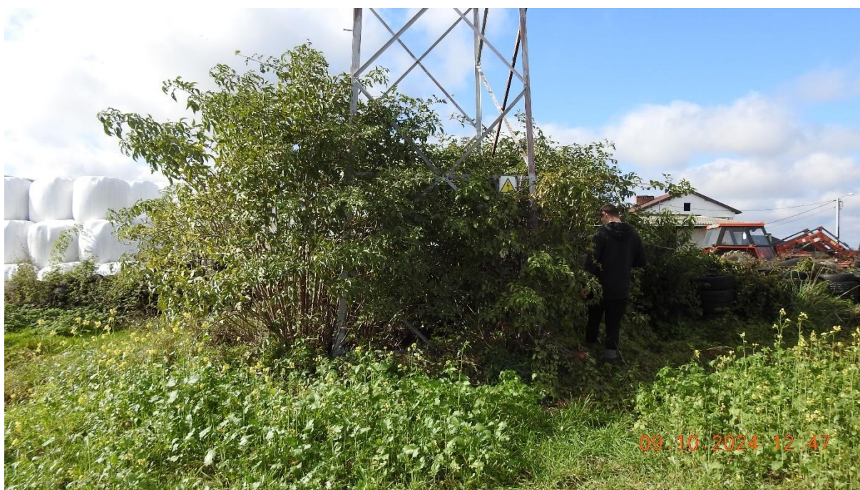
Grafika 18 Roślinność wrastająca na konstrukcję słupa na stanowisku nr 17.
