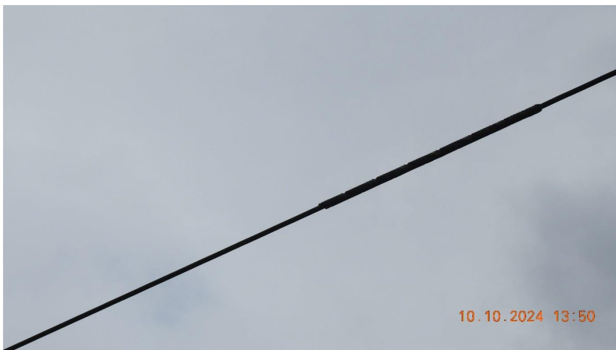
Grafika 56 Oplot naprawczy na przewodzie fazowym L1 w przęsle 62-63.
