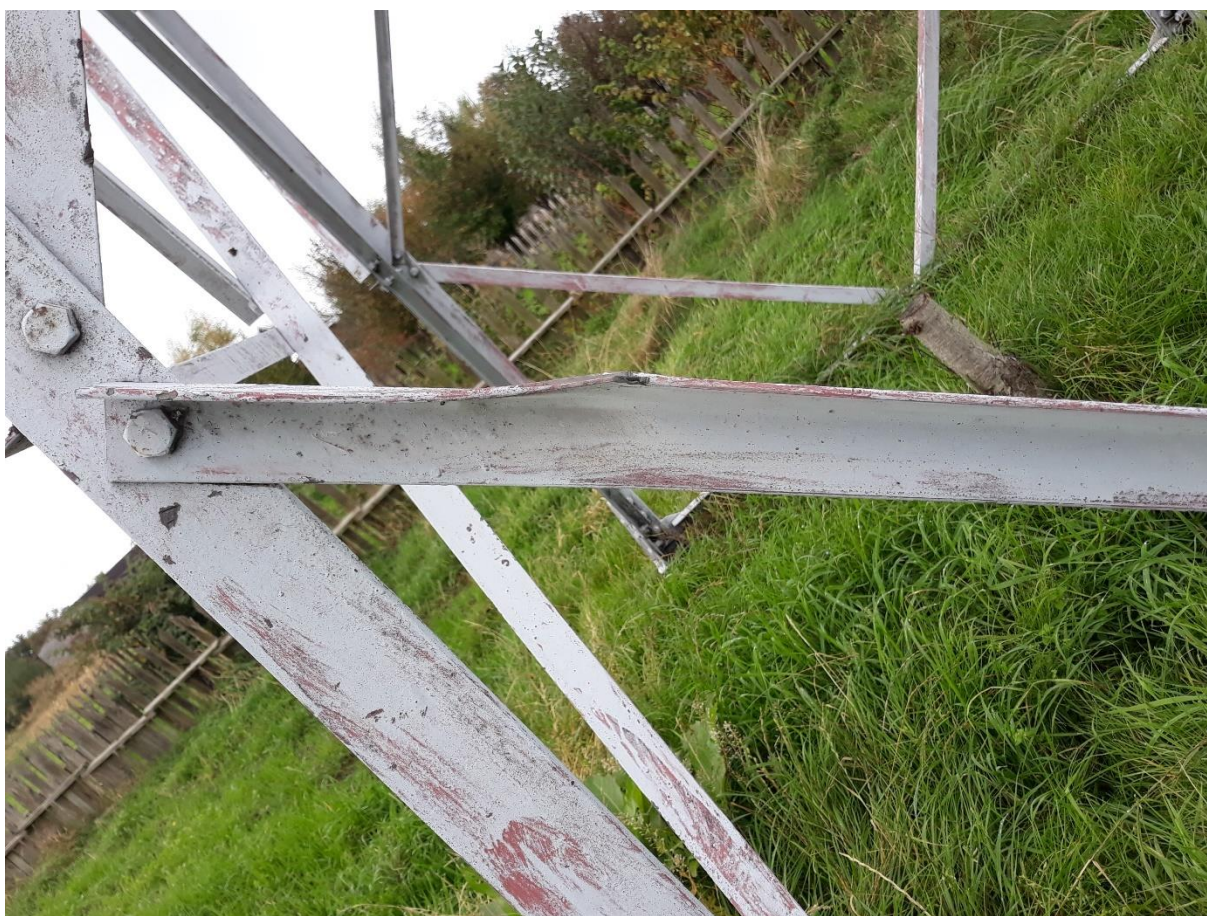
Grafika 16 Uszkodzona konstrukcja słupa nr 15.
