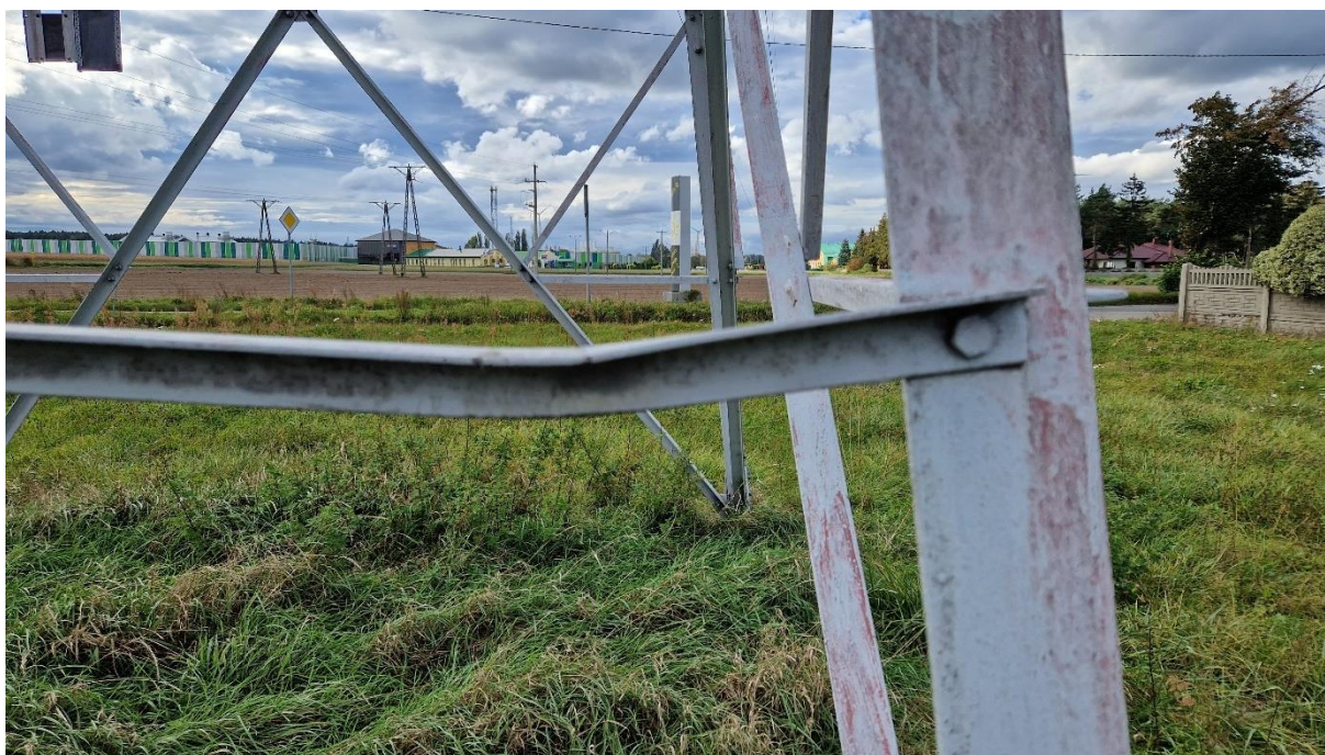
Grafika 53 Uszkodzone konstrukcji słupa nr 61.
