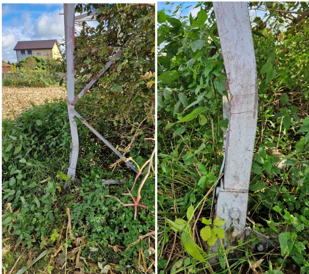
Grafika 19 Uszkodzona konstrukcja słupa nr 19.
