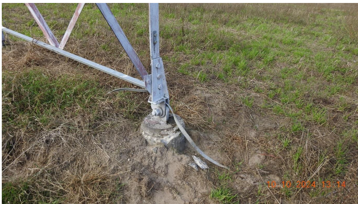
Grafika 52 Uszkodzone uziemienie słupa nr 58.
