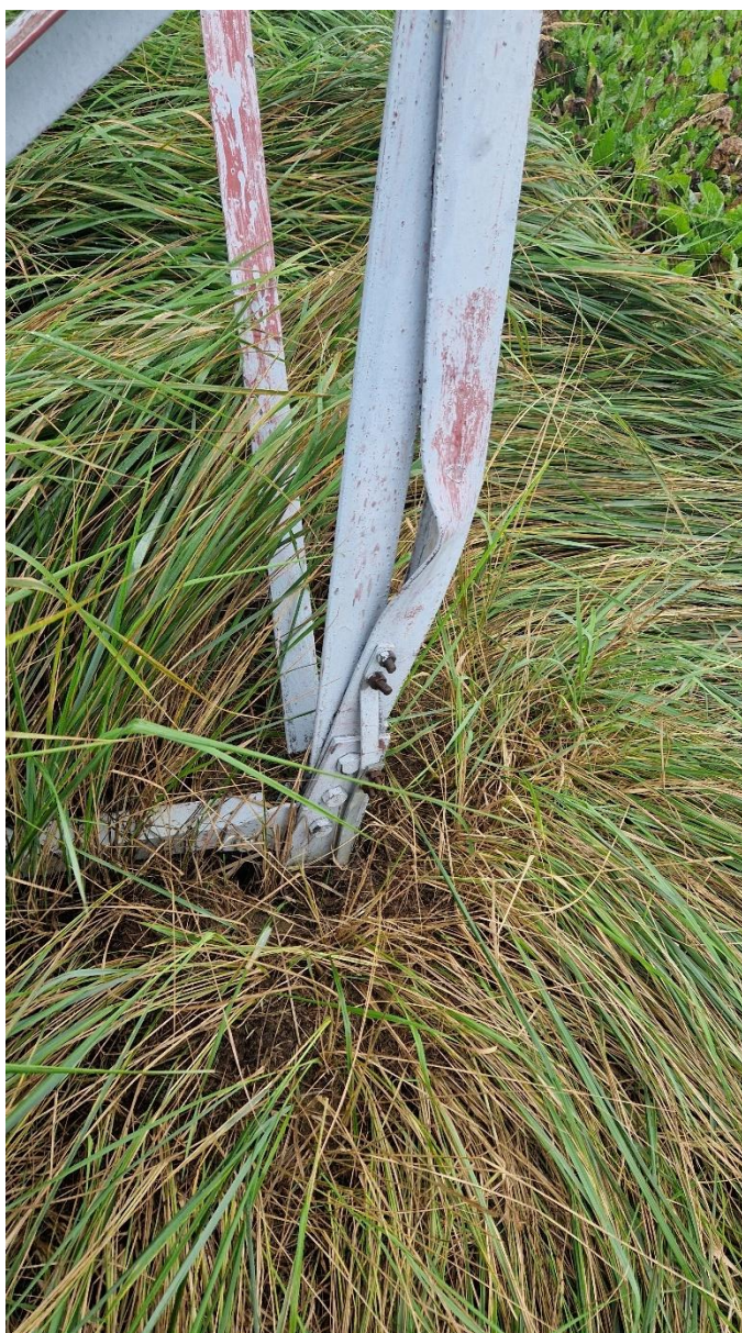
Grafika 1 Uszkodzony element konstrukcyjny słupa nr 3
