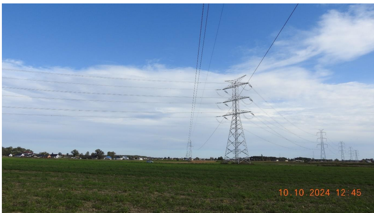
Grafika 48 Krzyżowanie linii WN z linią NN 400 kV Ostrów - Kromolice - przęsło 56-57.
