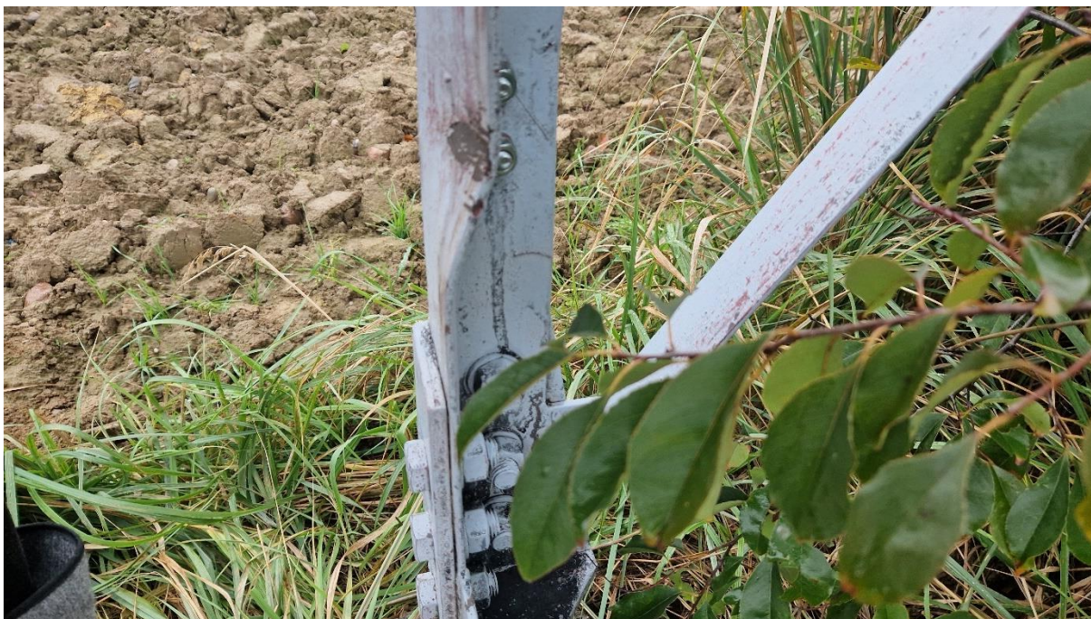
Grafika 7 Uszkodzony element konstrukcyjny słupa nr 9.
