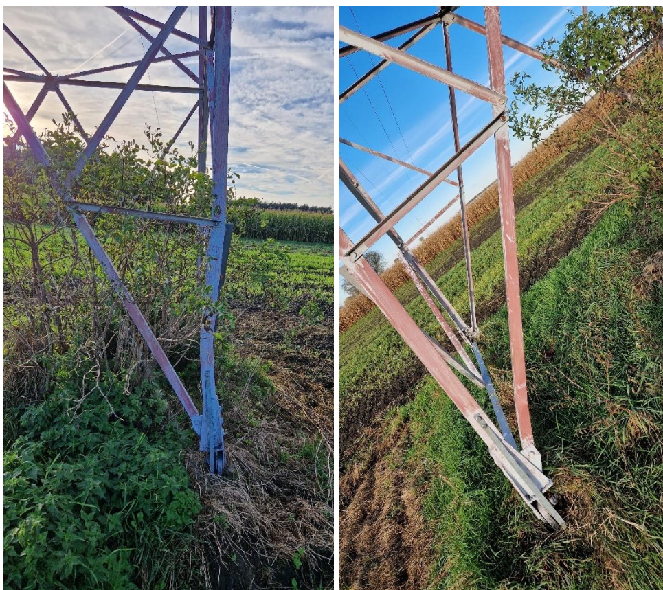
Grafika 32 Uszkodzona konstrukcja słupa nr 33.
